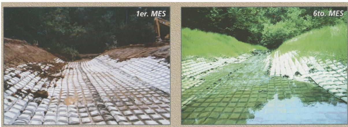
FIGURA 7. 10 Obra de protección del lecho de un cauce natural con Tapetes de concreto (imagen obtenida del catálogo de Submar-Elher)
