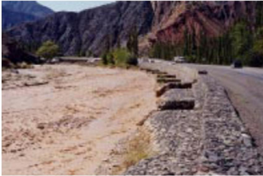
FIGURA 6. 6 Muros longitudinales con espigones
