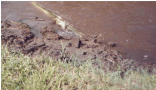
**Cuando la socavación del lecho del río llega hasta el tubo del cruce subfluvial el tubo queda sin protección contra la acción del flujo y se destapa rápidamente por sectores.**
