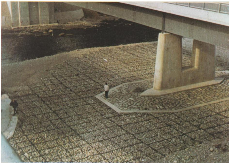
FIGURA 7. 9 Obra de protección total del lecho de un cauce natural, bajo un puente con gaviones (imagen obtenida del catálogo de Maccaferri Gaviones)
