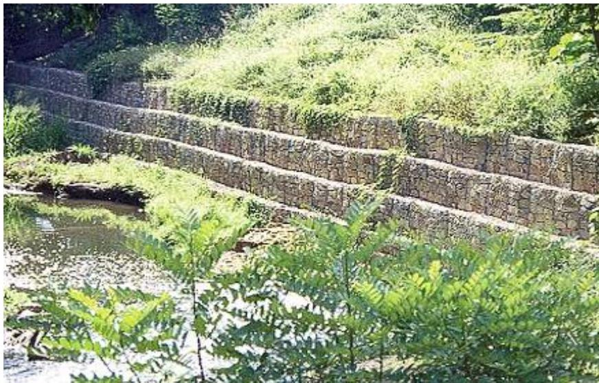
FIGURA 6. 5 Muro longitudinal con gaviones
