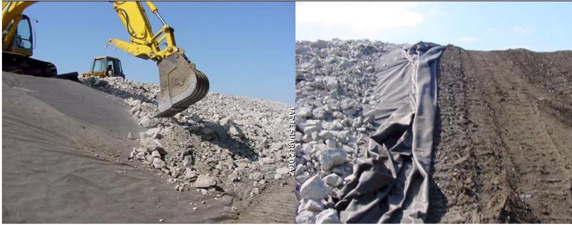
**Figura 6.10** Protección de taludes utilizando enrocamiento.
