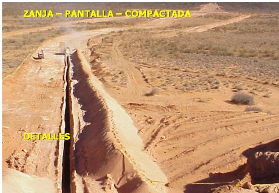
**Figura 6.19** Material de desplante de una pantalla impermeabilizante
