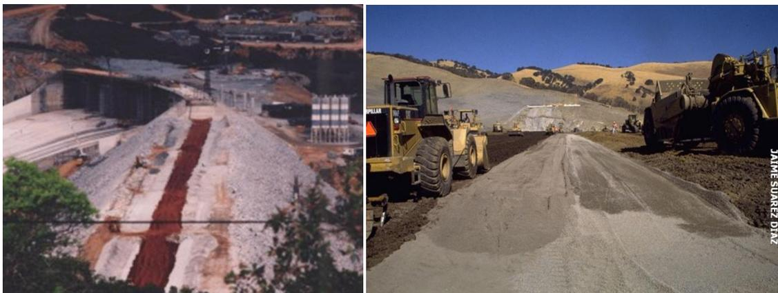
Figura 6.5 Espesor del núcleo en el apoyo de la cortina en las laderas de la boquilla
