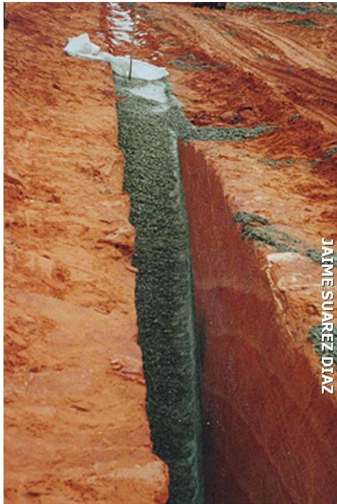
**Figura 6.20** Pantalla impermeabilizante de concreto
