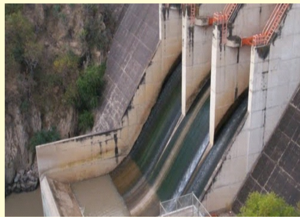
VERTEDOR DE LA PRESA LA BEGOÑA (SAN MIGUEL DE ALLENDE, GTO.)
